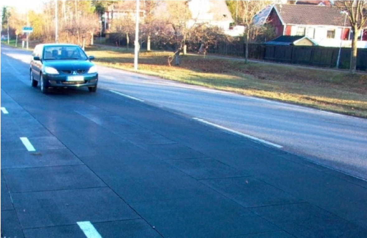
Abbildung 5: Teststrecke mit PERS-Belag nahe Stockholm (Schweden). Quelle: [Bendtsen et al.2005]
